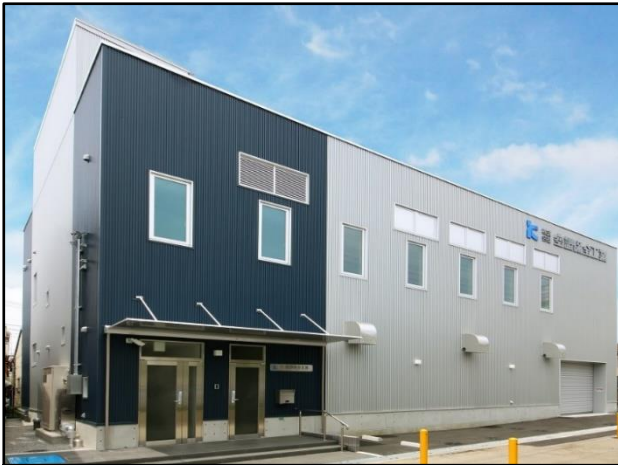
総合テクニカルセンター外観
